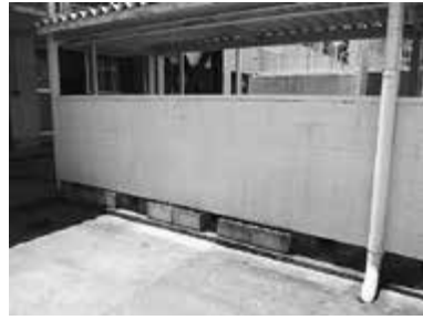
小学校内のブロック塀
